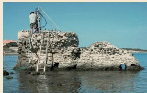
Eine antike Hafenmauer wird untersucht. Forscher fanden nun heraus, wie Salzwasser den Beton nach und nach härtete.
